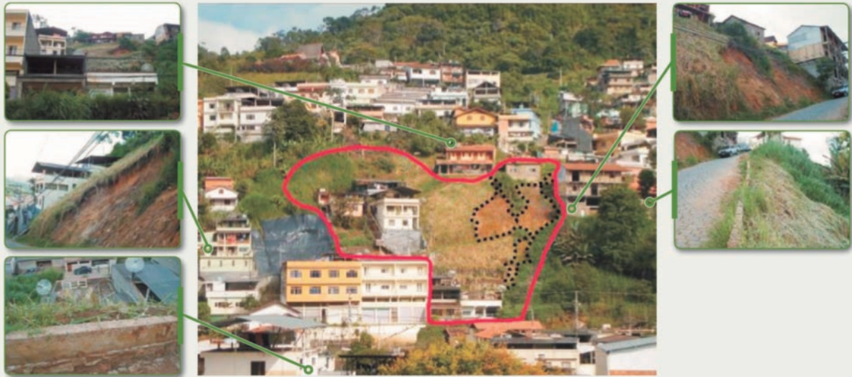
Mapeamento de risco remanescente – Nova Friburgo (RJ), na localidade de Ouro Preto.
