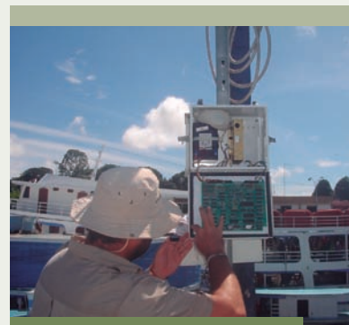
Manutenção em estação telemétrica – Oriximiná – Rio Trombetas.
