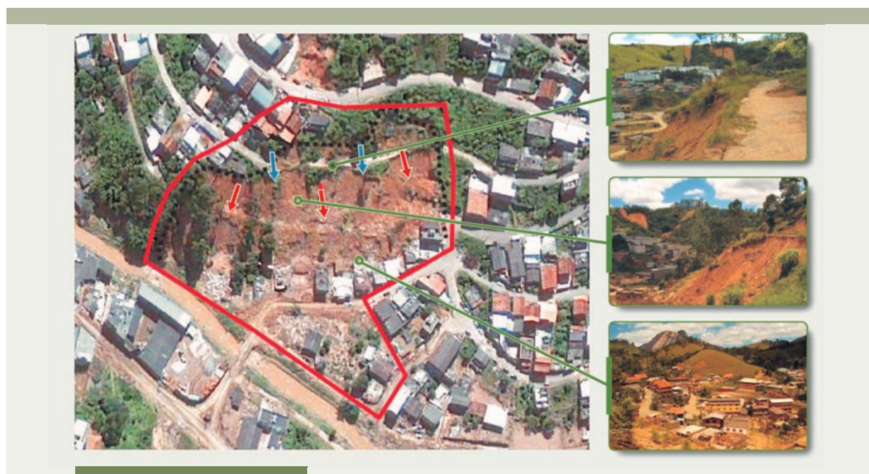
► Mapeamento de risco remanescente – Nova Friburgo (RJ), na localidade de Conselheiro Paulino - Jardim Califórnia.
