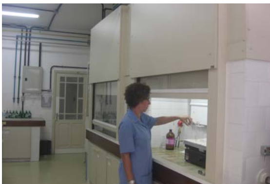
Readequação do espaço com a instalação de novas capelas de exaustão.
