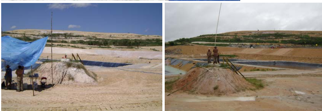
Vistas das lagoas de estabilização de chorume, instaladas a partir de 2008 na borda norte do aterro sanitário de Manaus, ao lado de poço de monitoramento perfurado para acompanhar a evolução da contaminação.
