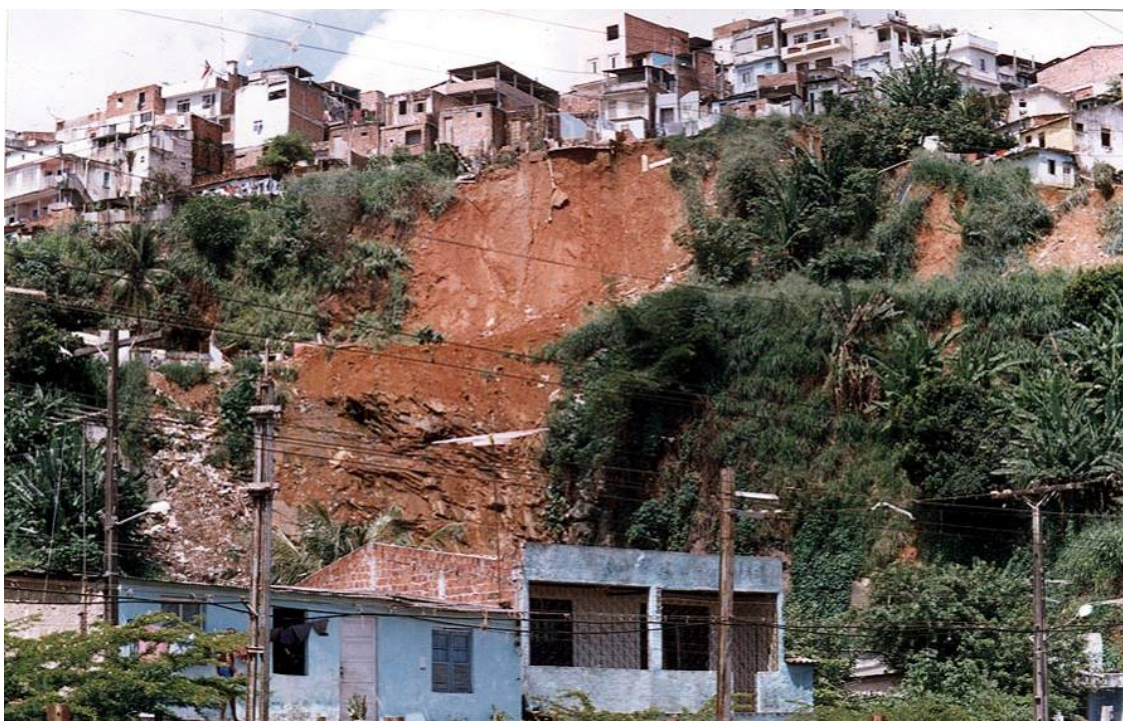
Deslizamento de encosta registrado no bairro do Lobato, em Salvador (BA).
