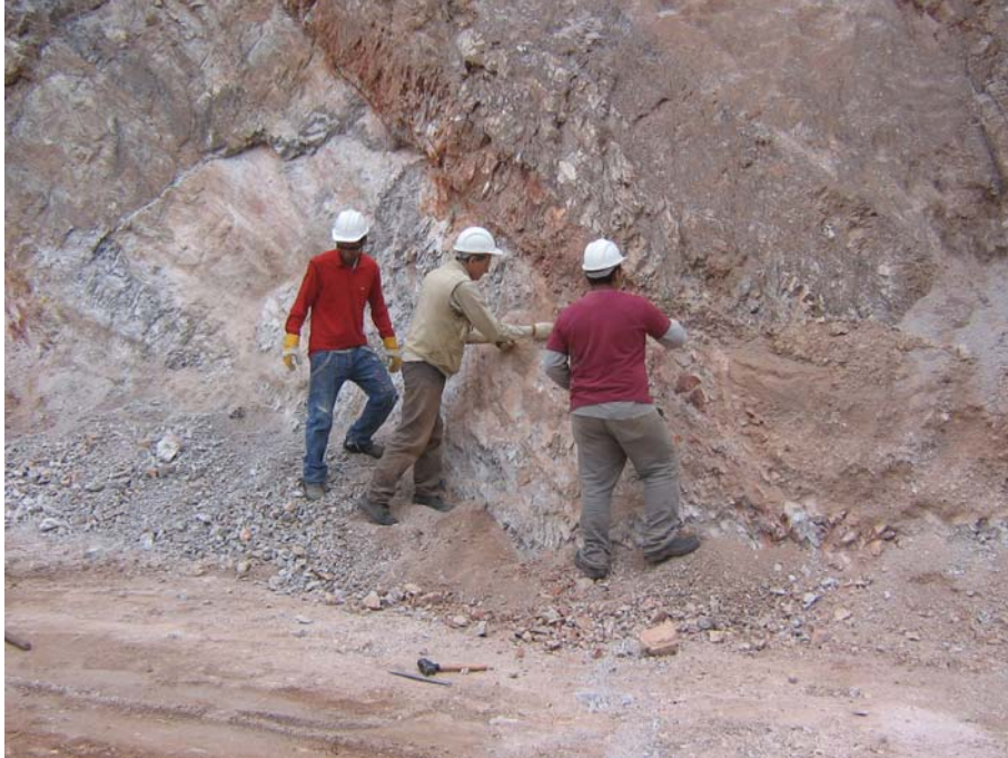
Amostragem em canaletas no calcário da frente de lavra da mina Copacel-Nobres (MT).
