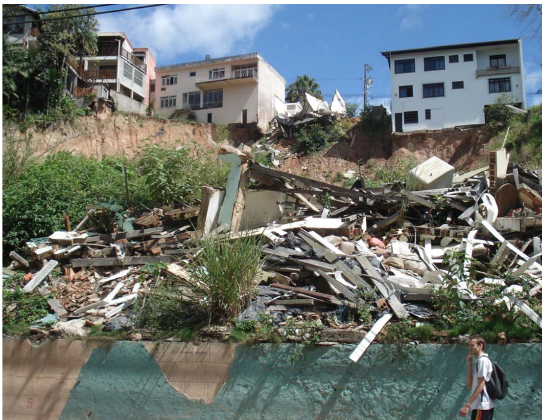
Escorregamento em encosta na área urbana de Blumenau (SC).
