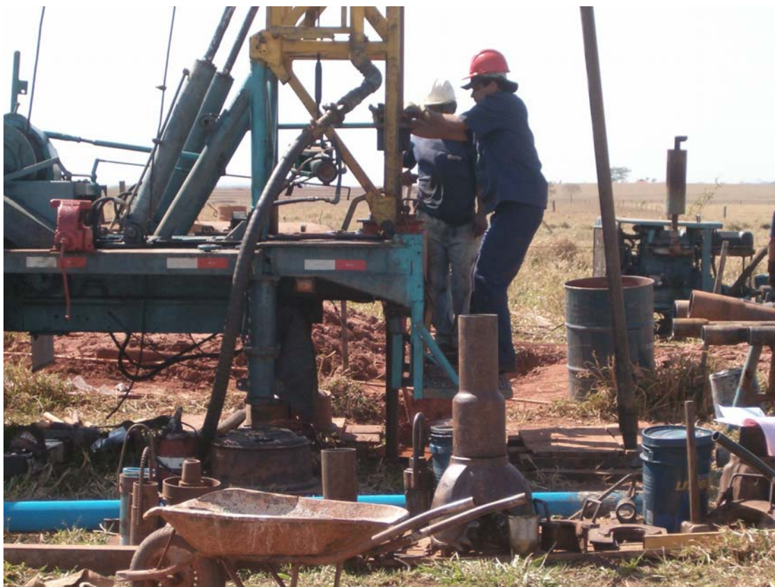
Perfuração de poço em assentamento rural no estado de São Paulo.
